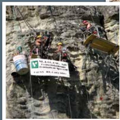
LAVORI IN PARETE Disgaggi, reti paramassi, paravalanghe e consolidamento pareti in genere.
