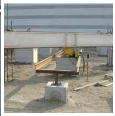
PROVE DI CARICO Prove di carico su pali, micropali e tiranti.
